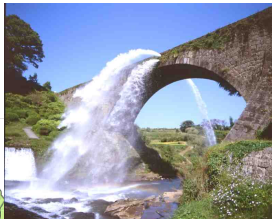
通潤橋 (国の重要文化財)
