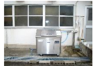
福地小学校 (平成23年10月25日設置)
