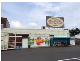
カーニバル本城店 生ごみ処理機 H18年11月設置
